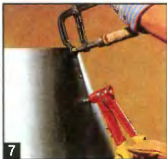
7 Внешний конусообразный колпак и внутренний теплозащитный экран топочной камеры собирают следующим образом. Края заготовки сводят вместе, скрепляют их струбцинами в верхней и нижней точках, сверлят отверстия и склепывают, продвигаясь сверху вниз.
