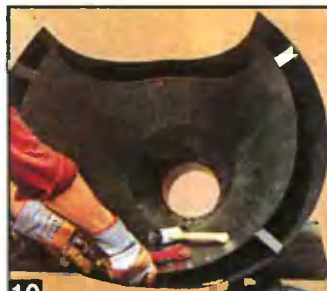
10 Тепловой экран также вставляют внутрь внешнего кожуха и крепят за нижнюю кромку с помощью П-образных кронштейнов на заклепках в 5–7 точках.
