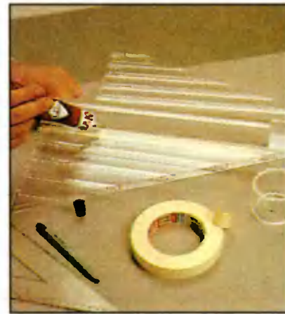
Вводя кабель в трубку, ее вклеивают между треугольными плитами. Чтобы выверить плиты по высоте относительно трубки, их кладут на бруски.
